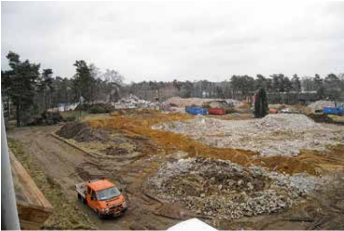
Abb. 2: Fortgeschrittener Gebäudeabriss im Zentralbereich des Kasernengeländes Foto: O. Miosga
